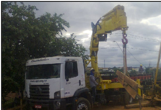
Figura 2 - Manejo de estaca metálica pela AP&L Geotecnia e Fundações.
