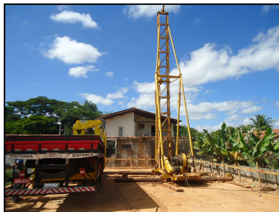
Figura 1- Canteiro de obra executada pela AP&L Geotecnia e Fundações.
